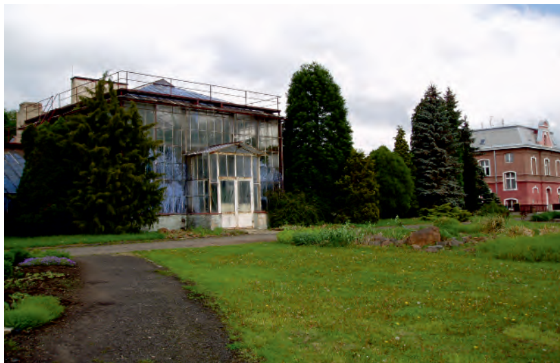
▲ Rok 2002 a dosluhující skleníky
