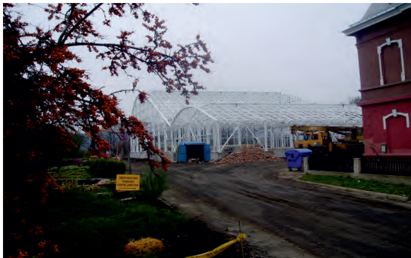
▲ Přelom roku 2004 a 2005 – stavba nového expozičního skleníku Tropicana
