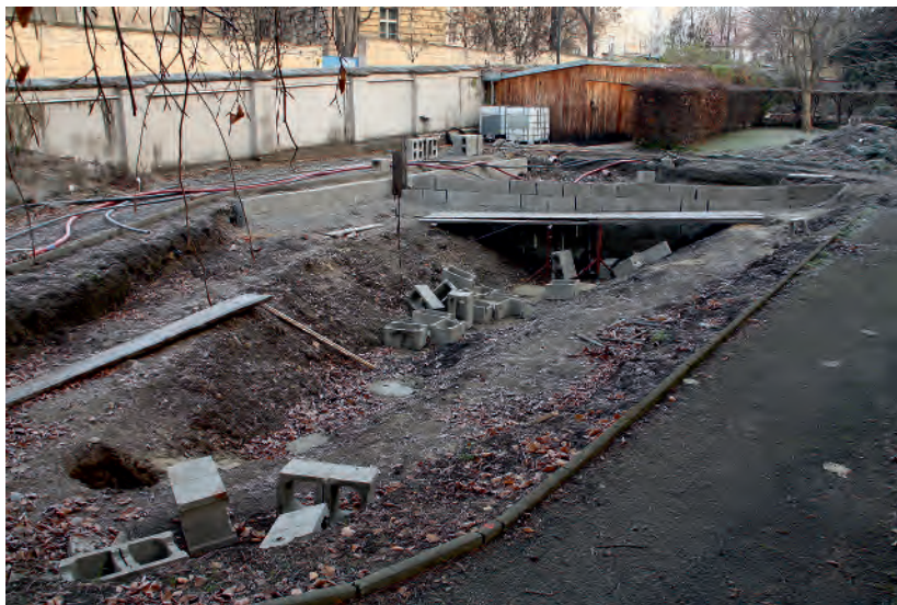
▲ Na stavbu zídky a opěrných sloupků pro dřevěnou lávku byly použity betonové tvárnice. Zídka odděluje rašelinnou a slatinnou část expozice
