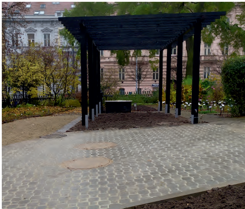
▲ Nová akumulční nádrž na dešťovou vodu je ukrytá v zemi. Nad ní je pergola sloužící k letnění hlavně subtropických rostlin
