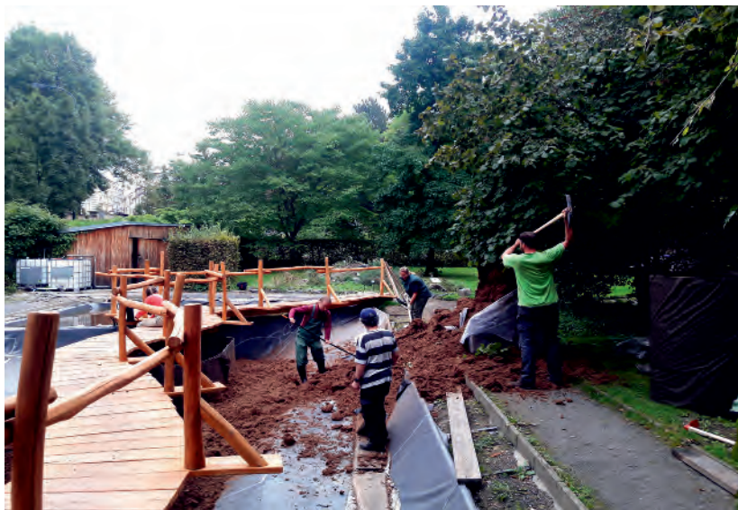
▲ Po vyfóliování jámy a dokončení dřevěné lávky přišlo na řadu naplnění expozice rašelinou. Na snímku jsou vidět podpěry vedené od okraje expozice (obrubníku), které nesou lištu k připnutí fólie
