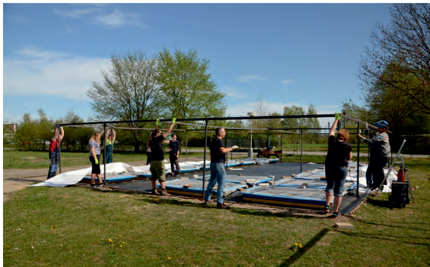
▲ Stavba pěstebních nádrží
